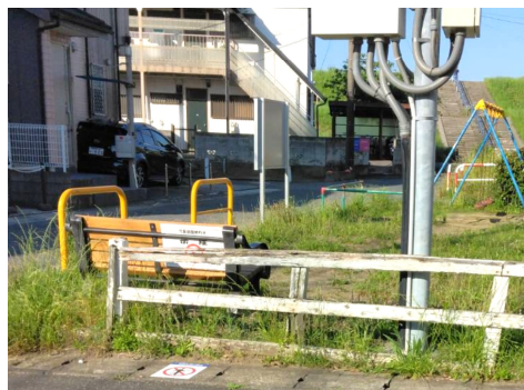
「ケガをする危険がある腐った外柵を改善してほしい」と市に要請しました
