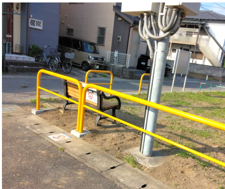
新しい外柵が設置されました
