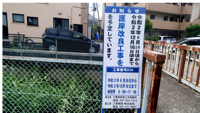
工事告知の看板：6月21日やなぎ撮影
