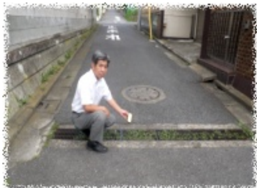
8月28日、宮久保地域を2時間調査。2丁目道路側溝上で0.54μSv(写真)、公園入口の側溝でも0.35μSvと高い値がでました。落葉が堆積した排水口や側溝、雨水により土砂等が堆積している箇所などが放射性物質が留まりやすい場所です。測定結果を基に地域における汚染マップを作製し、今後も除染対策を要望していきます。
