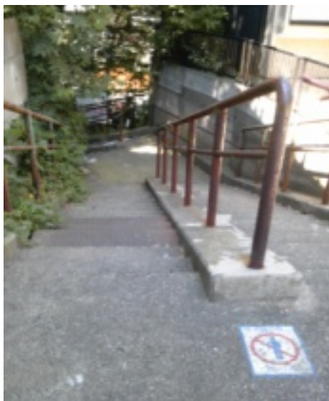
曾谷地域の「街灯を設置し明るくしてほしい」との要望を受け現地調査を実施（写真）
