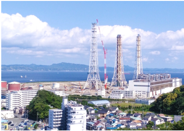
横須賀火力発電所 株式会社「JERA」Hjより
